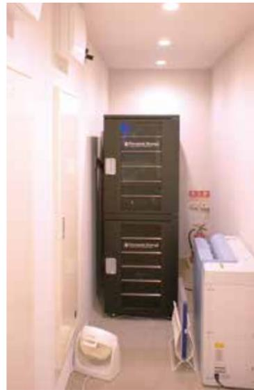
写真左：長野県たなべ診療所に設置されている、医用電気システム専用電源 PE-0601。安定化電源ソースとして、診療所の屋根に設置している太陽電池から、クリニックすべての電力を供給している。
