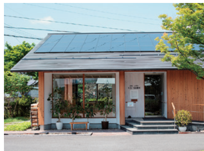
屋根に設置したソーラーパネルによる 太陽光発電が主電源となる
